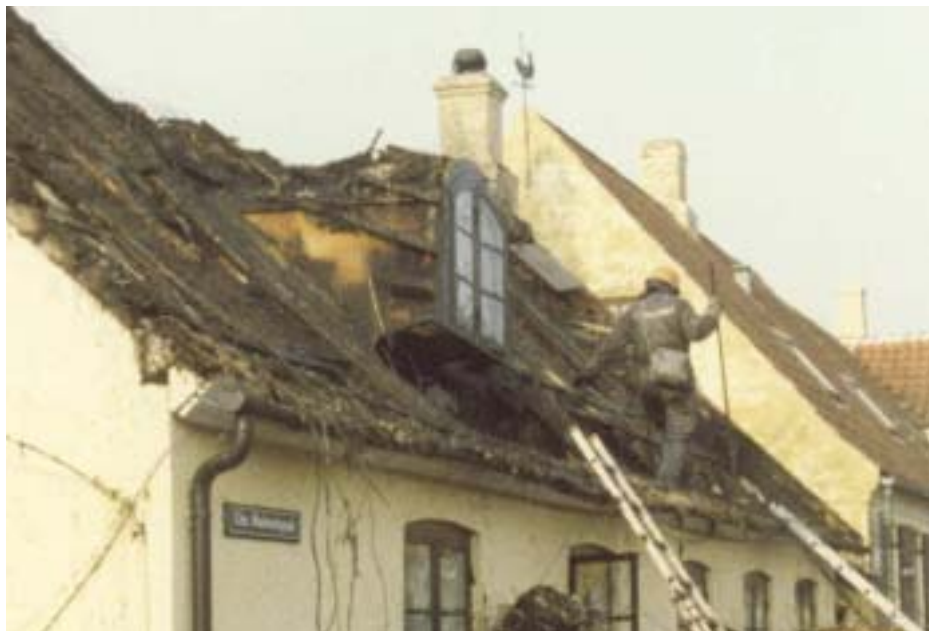
Oprydning i Chr. Mølstedsgade efter branden i 1988.
